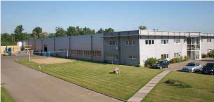
Das Sileo-Werk in Salzgitter-Watenstedt
